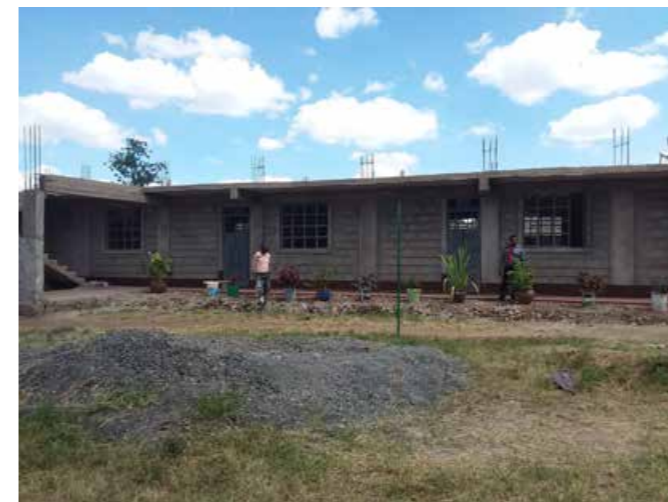
Der Ausbau der Schule wird fertiggestellt
